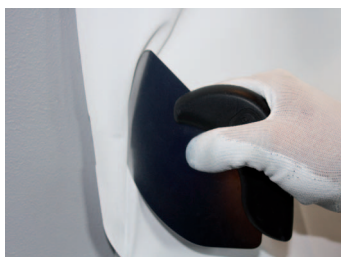
Prendendo o revestimento no perfil.
