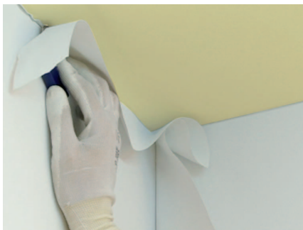
Apare o revestimento por todo o comprimento usando um estilete.
