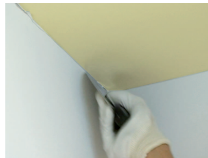
Pressione a margem de excesso do revestimento no vão do perfil.
