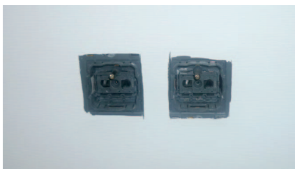
Corte no revestimento.
