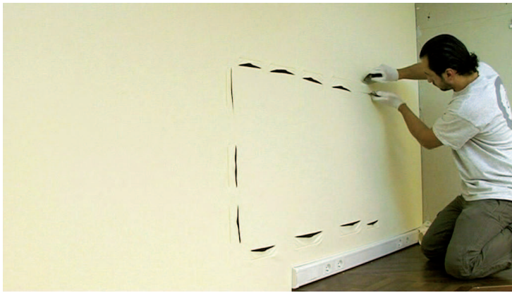
Faça cortes no revestimento.
