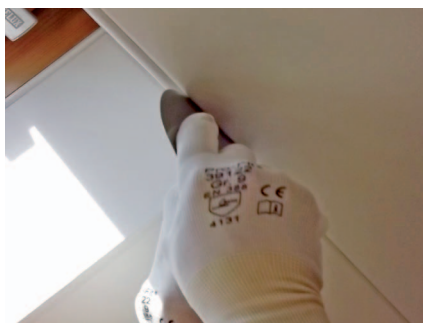
Corte no revestimento.
