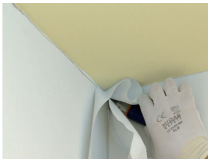
Para os cantos, use o estilete para remover o resto do revestimento.
