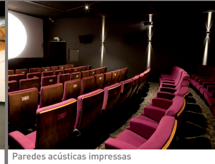
Paredes acústicas impressas
