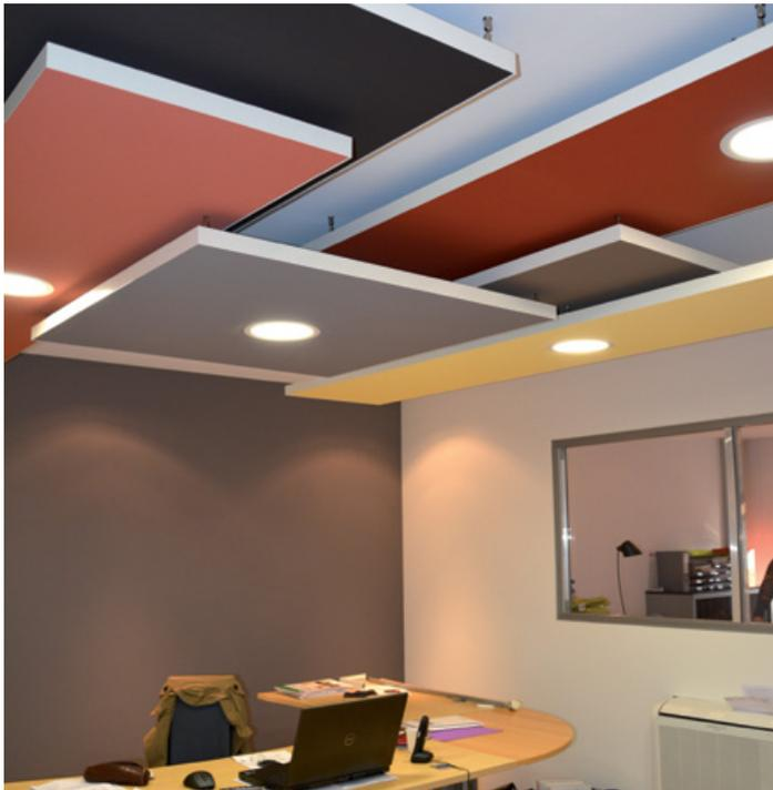
As nuvens acústicas AEROCEILING são cobertas com tecido microperfurado e manta acústica, colocados dentro da estrutura de alumínio da moldura. Os espaços de Plenum entre a trama acústica e a manta aumentam o desempenho acústico da sua nuvem.
