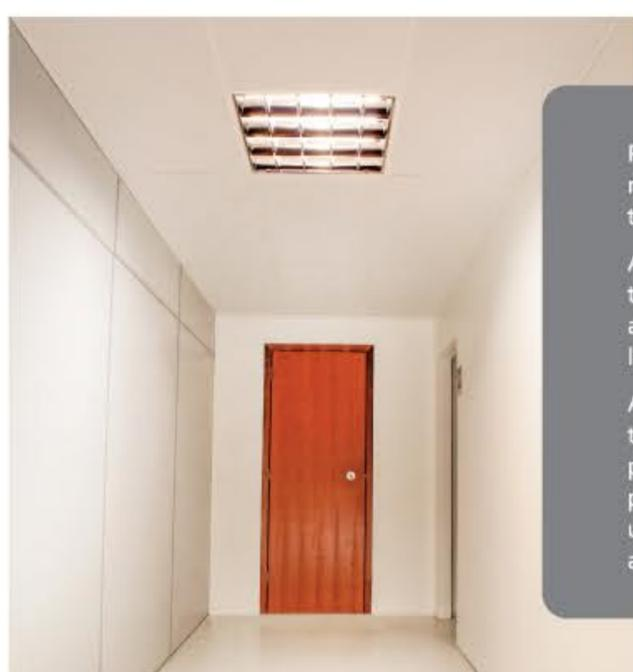
Placas de forro em gesso acartonado com revestimento frontal de película de PVC branco texturizado e face posterior aluminizada.
